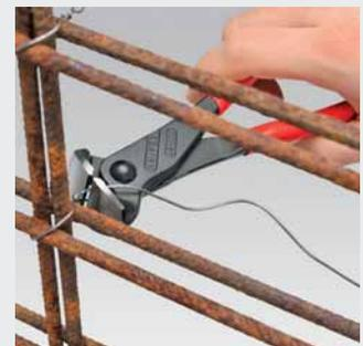
Die Kopfform ermöglicht einen optimierten Bewegungsablauf beim Spannen des Flechtknötens bei Monierarbeiten.
