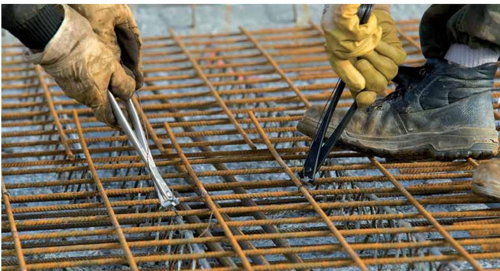
*Monierungen sind Handarbeit – überall auf der Welt, in verschiedensten Gebäuden. KNIPEX-Monierzangen bieten den Bauarbeitern eine leistungsstarke, ergonomische Lösung für ihre Herstellung.*
