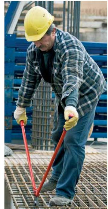
Die besondere Kopfform des Mattenschneiders 71 82 950 ermöglicht das Schneiden flachliegender Baustähle
